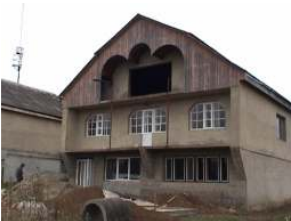
FTCH Nagyberég in aanbouw
