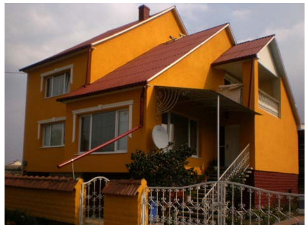
FTCH Tiszabökény voorzien van isolatie aan buitenzijde
